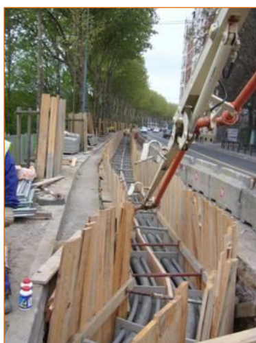
Pose en fourreau PVC enrobé de béton
